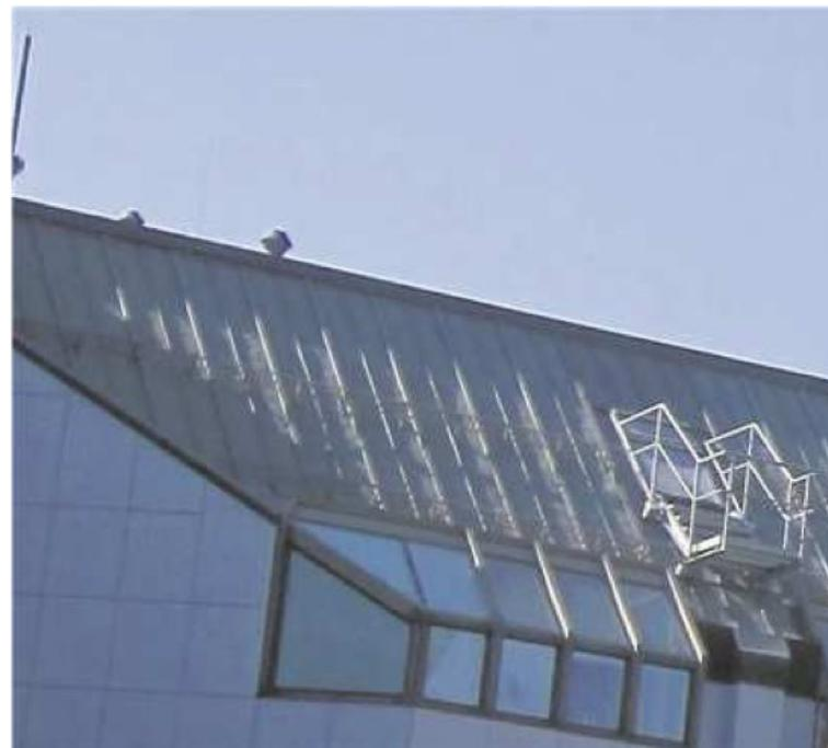
Image 2: balcon pour nettoyage de verrière
