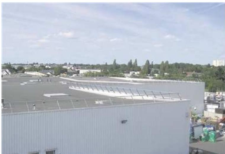
Image 1: garde-corps en bord de toiture
